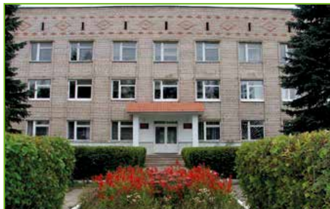
Здание РУП «Институт льна»
